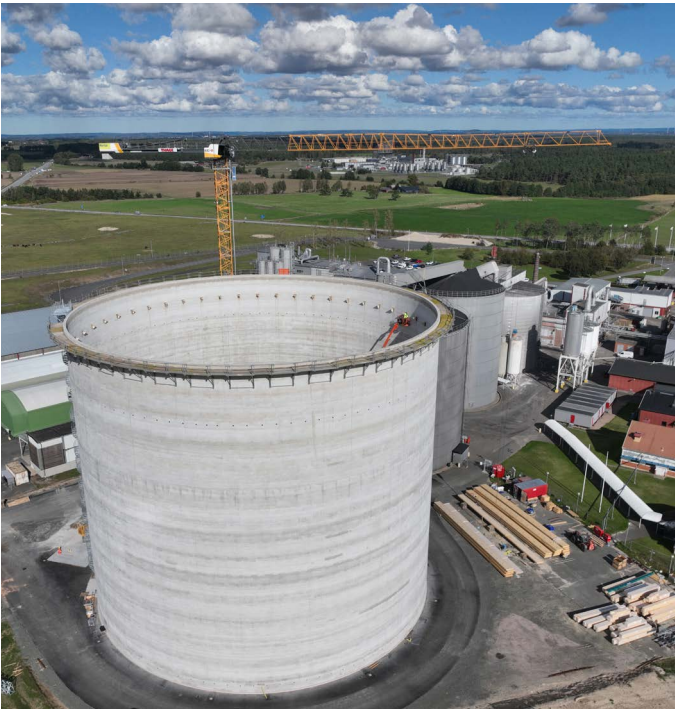
Den 30 september monterades konsoller till räls för bryggan på den nya silon i Nöbbelöv.
