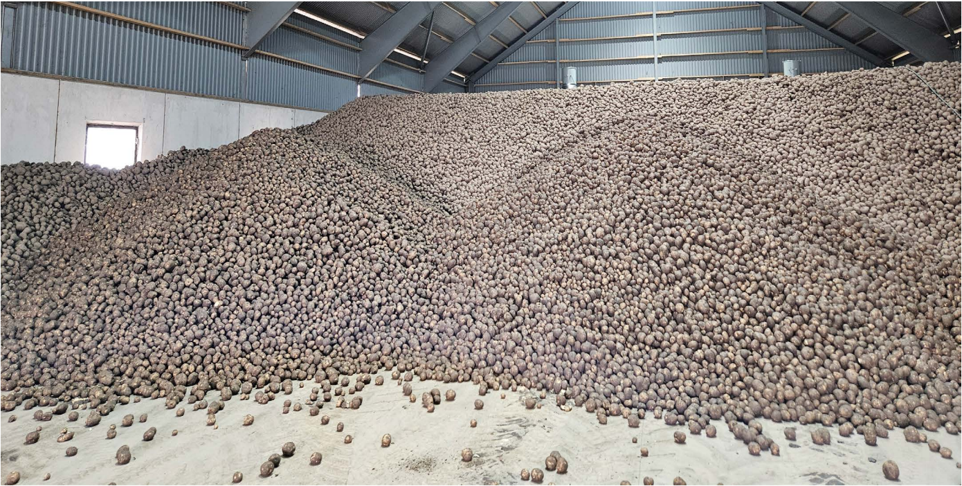
Idag lagras en del av potatisen, ca 900–1000 ton, i ombyggd grisstall med fläktar i bingen på Ekedala. Till nästa år ska det byggas ytterligare 1100 m2 inomhuslagring samt lagring under tak på ett par ställen i fält.
